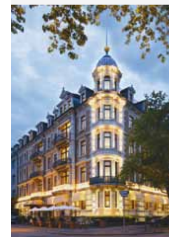
Hotel Alden Splügenschloss, Zürich.
